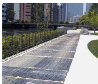
建築現場車両通路
