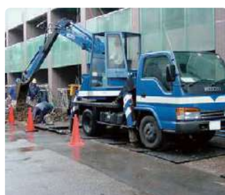
マンション外溝工事
