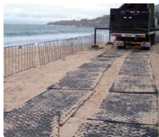
護岸工事(砂地養生)
