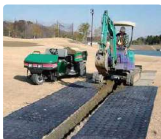
ゴルフ場整備
