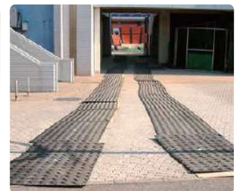
インターロッキング養生
